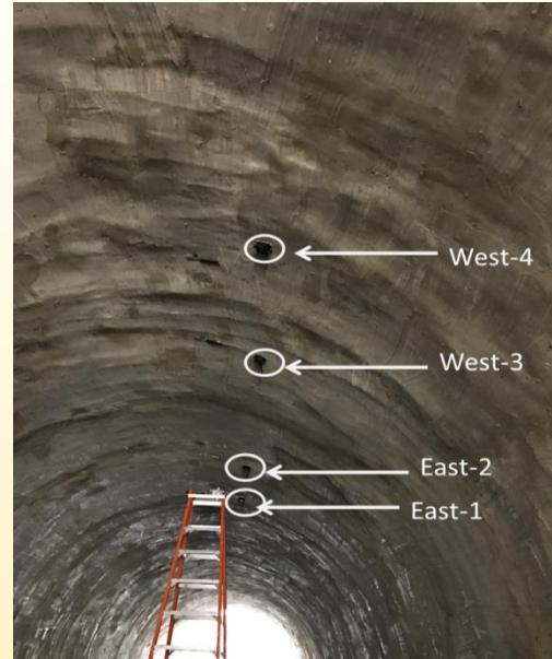
À l'aide du système, un test de charge vive a été utilisé pour confirmer l'intégrité structurelle de la structure et pour s'assurer de sa capacité à résister à sa charge nominale.
